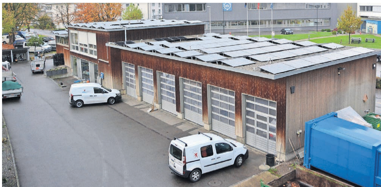
Auf dem 300 Quadratmeter grossen Werkhofdach wurden 164 Photovoltaikmodule installiert.
